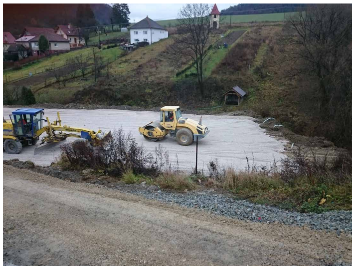
Výstavba viacúčelového ihriska v Babkove Foto: OÚ
