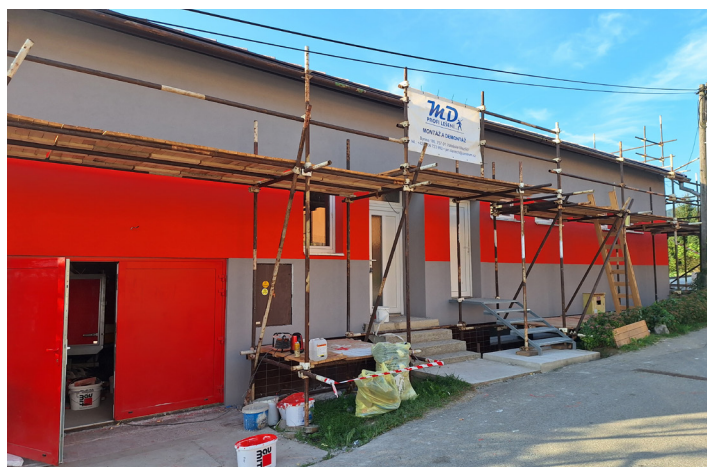
Tento rok sme dokončili zateplenie Hasičskej zbrojnice v Babkove. Skôr, ako sa začalo zatepľovať, bolo potrebné vymeniť dvojce garážových dverí a dorobiť bočné vchodové dvere do garáže.
