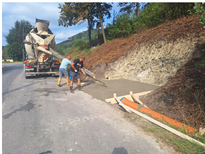
V časti Zámostie sme vyrobili a osadili novú autobusovú zastávku. Z dôvodu stavby a samotného prístupu k rodinnému domu sme po konzultácii so SAD Žilina realizovali presun na nové miesto z pozemku súkromného na obecný.
