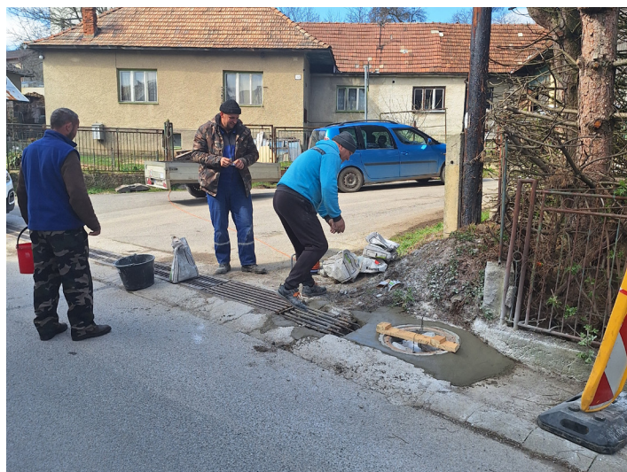
Oprava žlabov na miestnych komunikáciách realizované počas roka.
