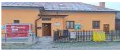
1 kus AED na budove OcÚ Lietavská Svinná
